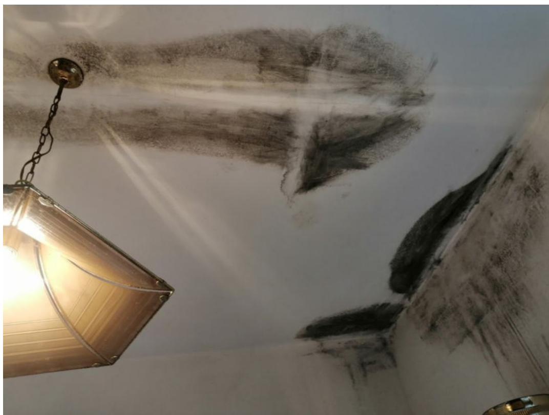
Foto 4: macchie derivate da infiltrazioni di umidità nella camera lato sud ovest
