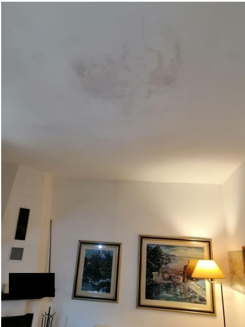
Foto 5: soggiorno con macchia di umidità sul soffitto
